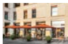
Juillet 2020 Tertianum Am Rietpark à Schlieren Le nouvel établissement
