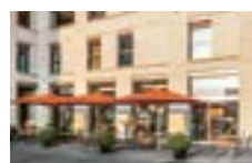
Luglio 2020 Tertianum Am Rietpark a Schlieren
