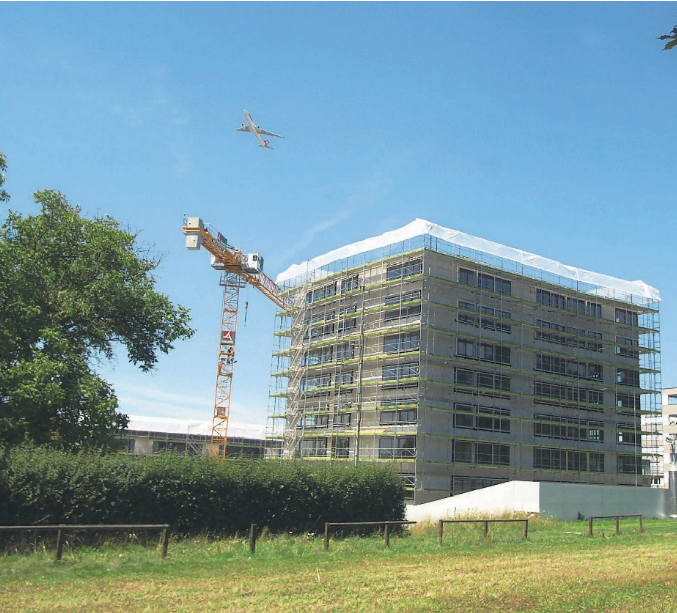
Im Juli 2014 war das Tertianum noch im Bau. Seine Nähe zum Flughafen ist für viele Bewohnerinnen und Bewohner ein Pluspunkt.
